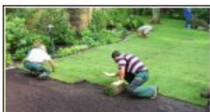
Der zu verlegende Rasen weist eine Stärke von ca. 3 cm auf. Neben Terrassen ist eine Höhendifferenz von 3cm unter den Anschlüssen ein zu halten. Dies hat den Vorteil, dass die Grasnarbe die Anschlüsse, z. B. Randsteine, später nicht überwuchert. Dadurch lässt sich eine Anlage pflegeleichter gestalten.
